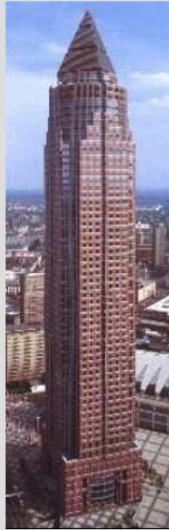
Messturm Frankfurt 24 elevators
